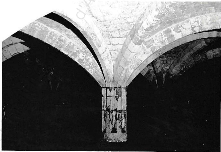
Abbaye du Montcel. Aile Nord Piliers sans chapiteau
