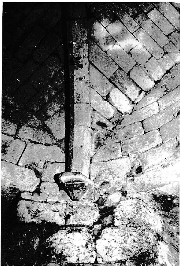
Console des salles gothiques de la tour n°16
