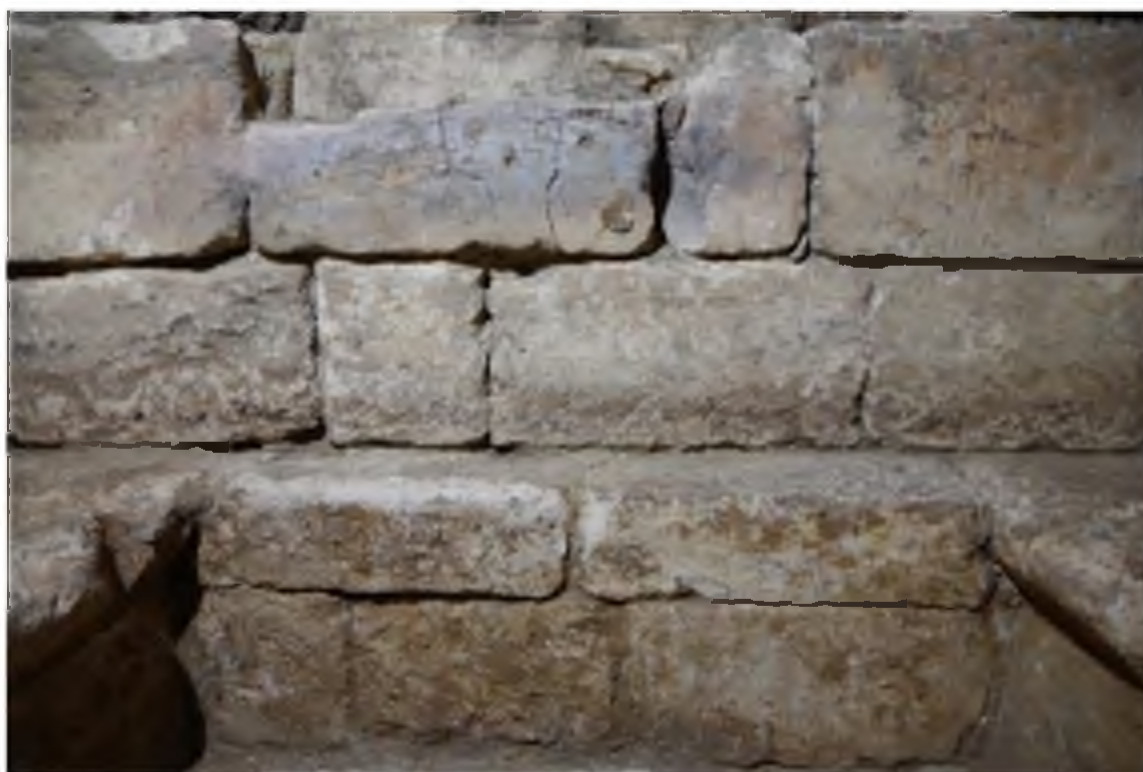
Détail des premiers bouchons de la baie ; remarquez que celui qui prend place entre les coussièges, peut-être dès le XIV e siècle, est lié à la terre
