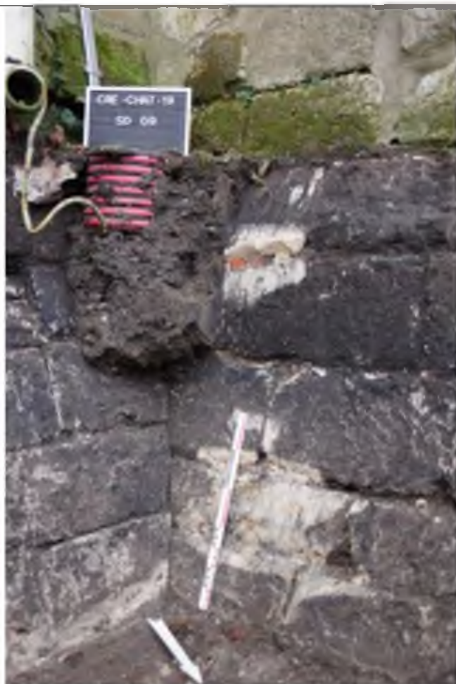
Détail de l'accolement du talus de la tour A4 à celui du mur-gouttereau
