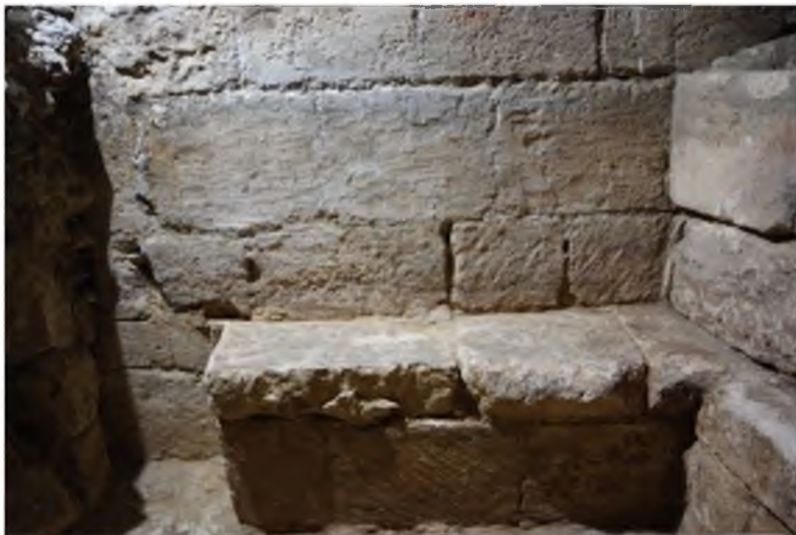
Détail du coussiège occidental ; remarquez toutes les traces d'outils (marteau-taillant droit)
