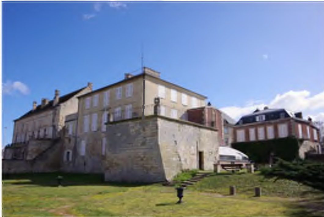
Vue générale du sondage au nord-ouest avant l'opération
