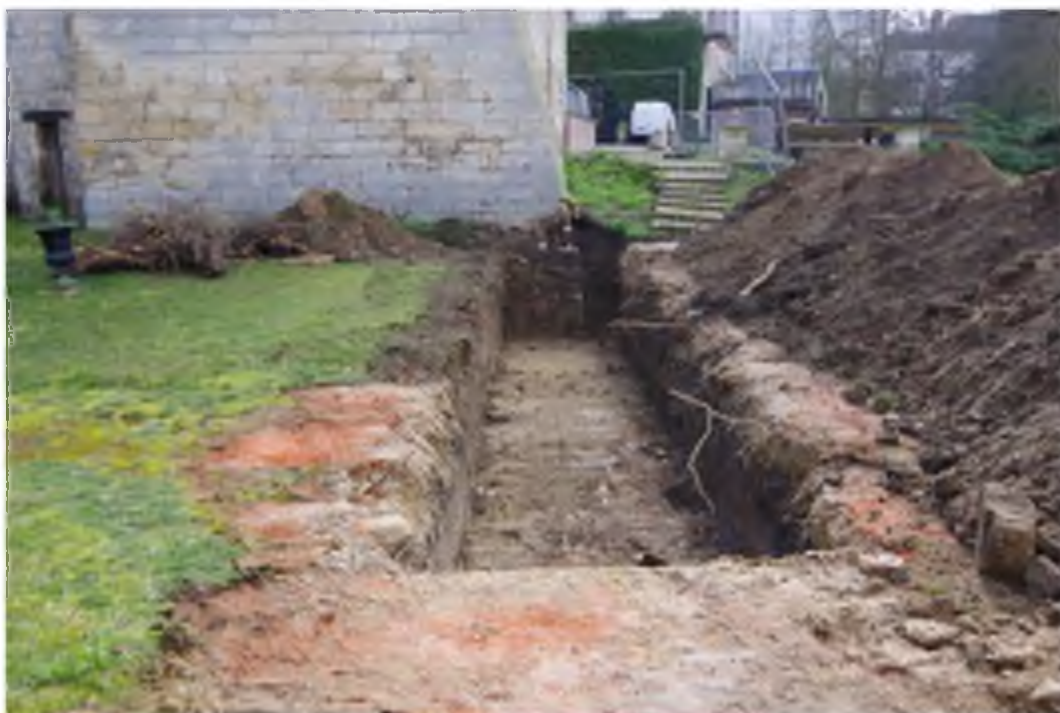
Vue générale de la tranchée de sondage débutant au pied du pavillon d'angle A3
