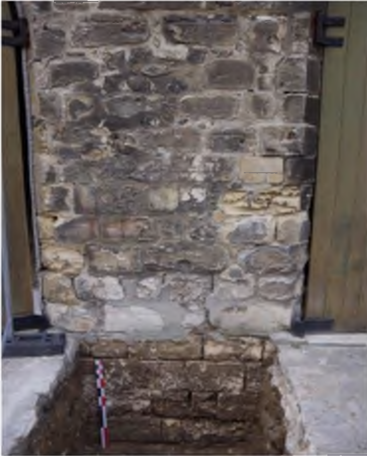
Le parement du mur-guttereau US 1017 à l'emplacement du sondage
