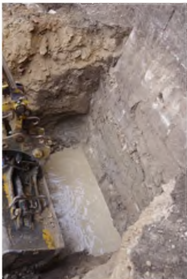
Détail du sondage profond au cours du dernier passage de godet
