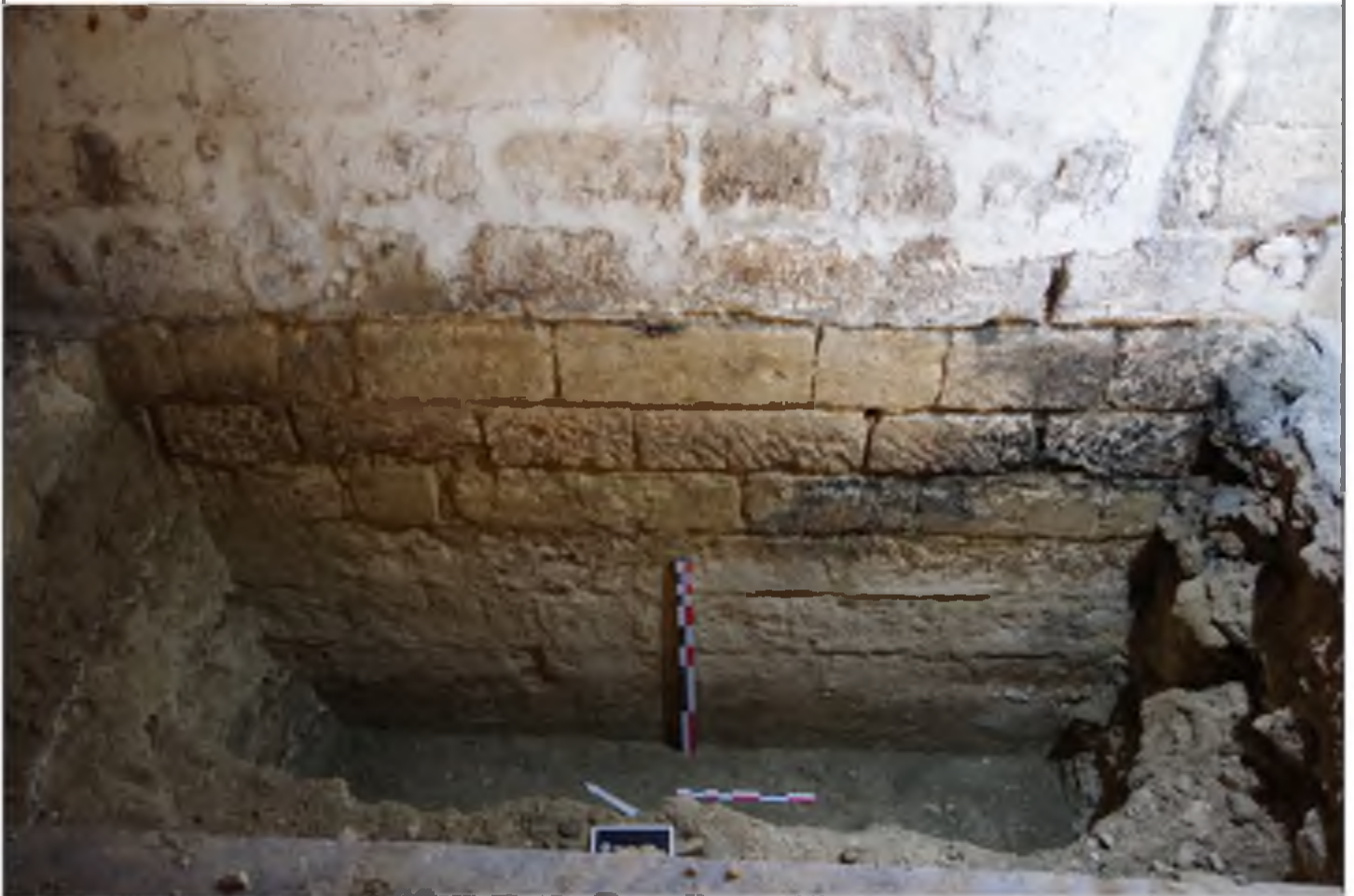
Vue générale du parement interne du mur-pignon US 1011
