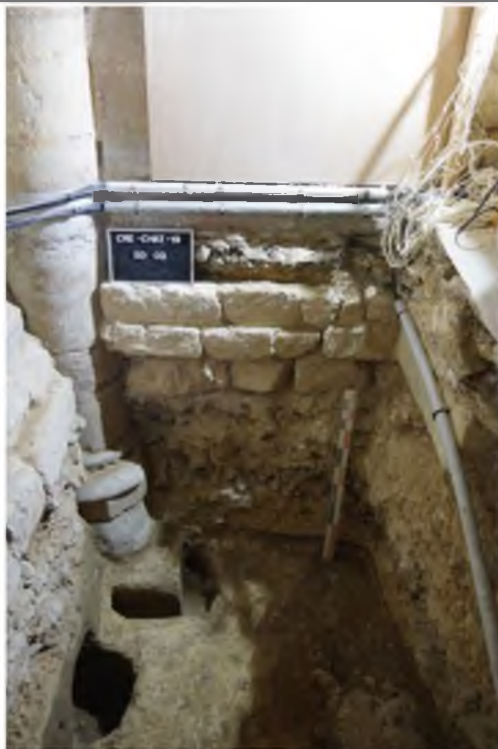
Vue générale de la berme sud et de la fondation du mur US 1032
