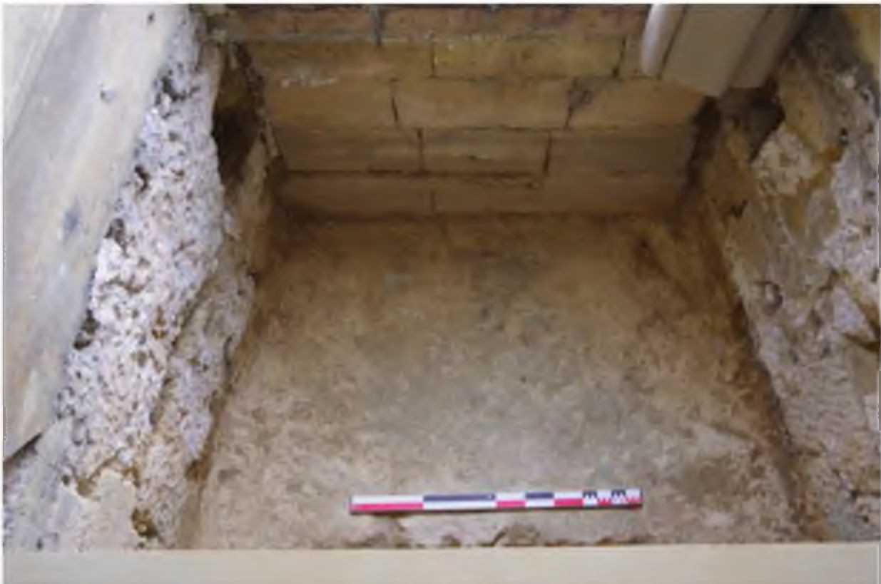
Détail du mur-bahut de la fenêtre qui forme le fond du sondage
