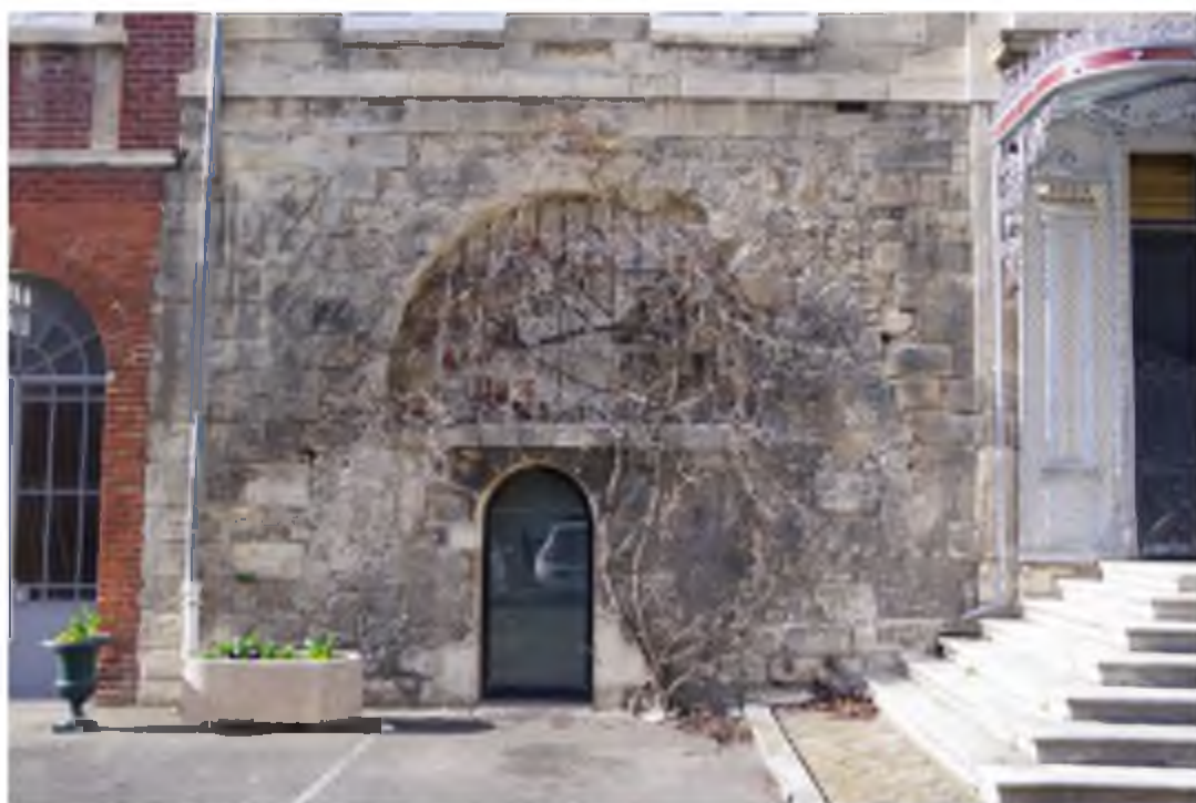
Le mur US 1023 et la fenêtre US 1024, avant l'opération
