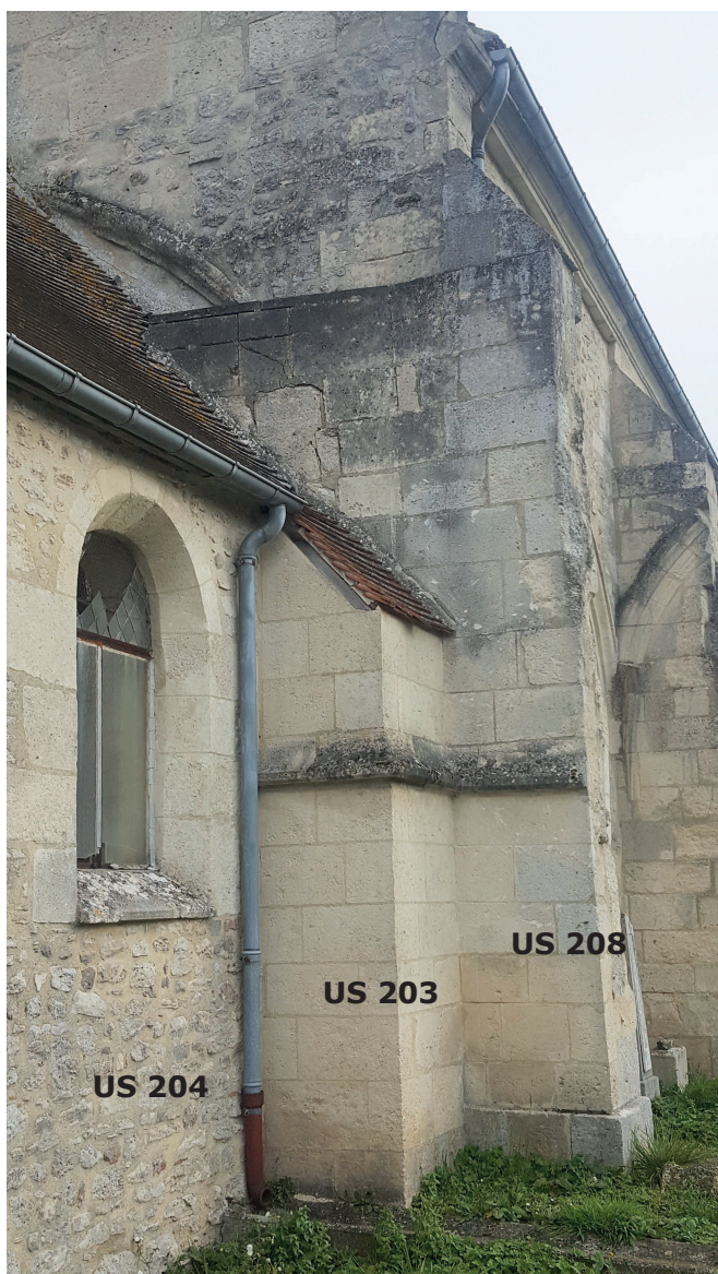
Détails de l'angle sud-ouest de la croisée avant l'opération
