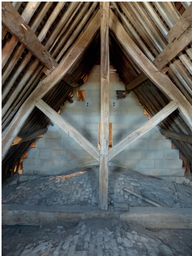
Vue générale de la ferme de la charpente du chœur
