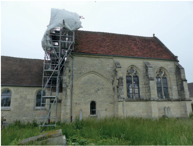
Le secteur du sondage 1 avant l'opération
