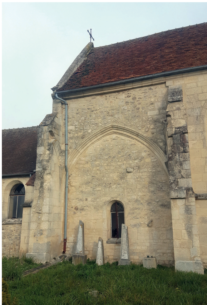
Vue générale des élévations actuelles
