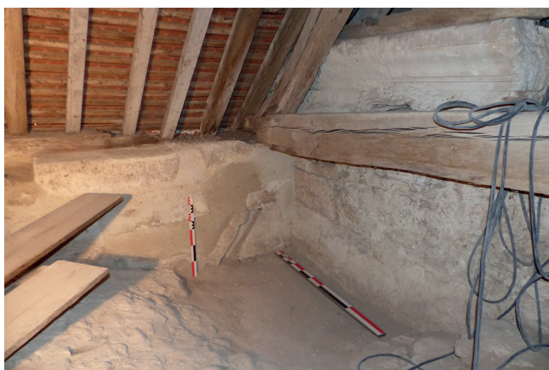
Détail du talus du contrefort sur lequel s'adosse l' US 215
