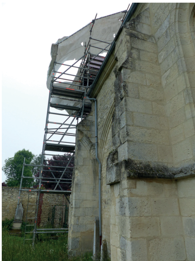
Détails des arrachements de l' US 208
