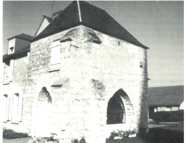
Vestiges de la tour médiévale de la ferme de Néry (Mesqui 1986)
