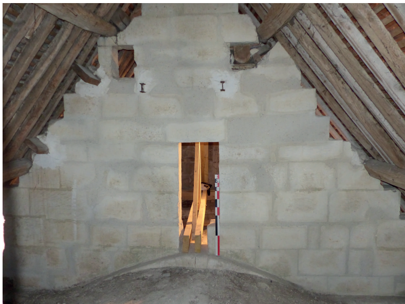
Face intérieure du mur de l'ancien clocher
