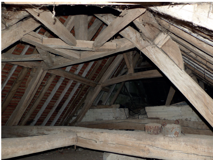
Vue générale de la charpente du croisillon nord
