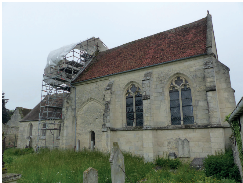
Vue générale du chœur depuis le sud
