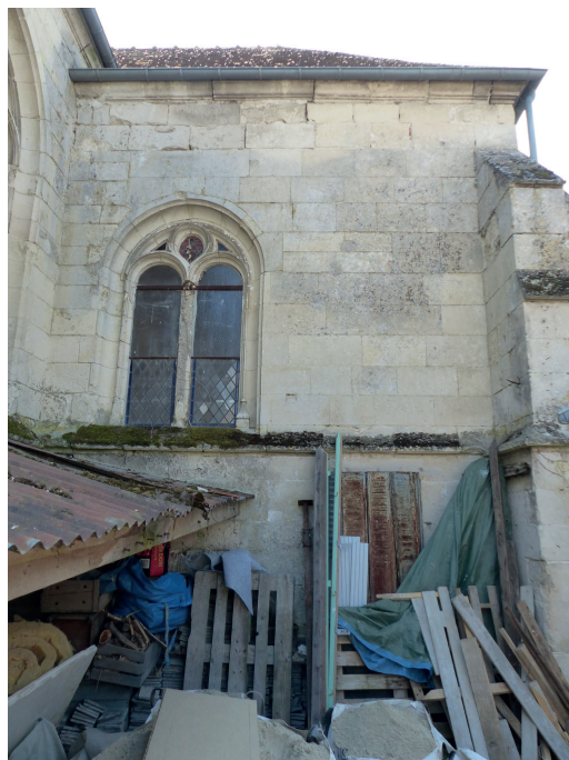
Baie du mur US 215 du croisillon nord dont l'épure dessine le réseau
