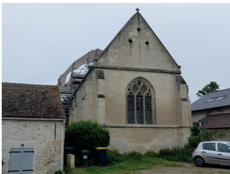
Vue générale du chevet
