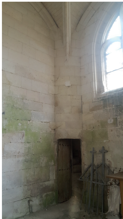
La tour-escalier en vis du croisillon nord, vue depuis l'intérieur
