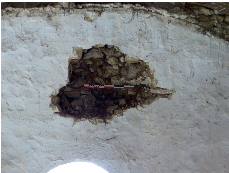
Sondage de visite (négatif) réalisé pour rechercher l'éventuel oculus ancien
