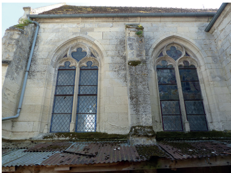
Détail de la face extérieure du mur-guttereau nord du chœur
