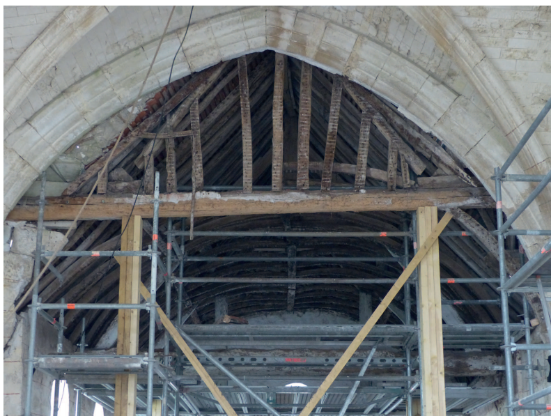
Vue générale de la charpente de la nef depuis le chœur
