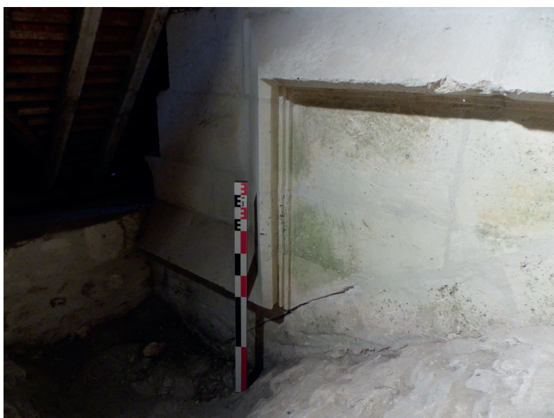
Détail de la moulure du larmier brisé du clocher
