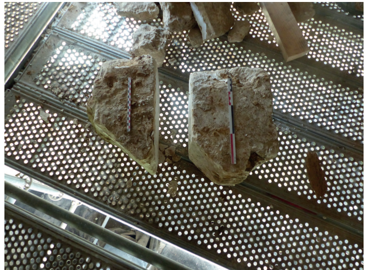
Blocs en remploi découverts dans le mur de façade
