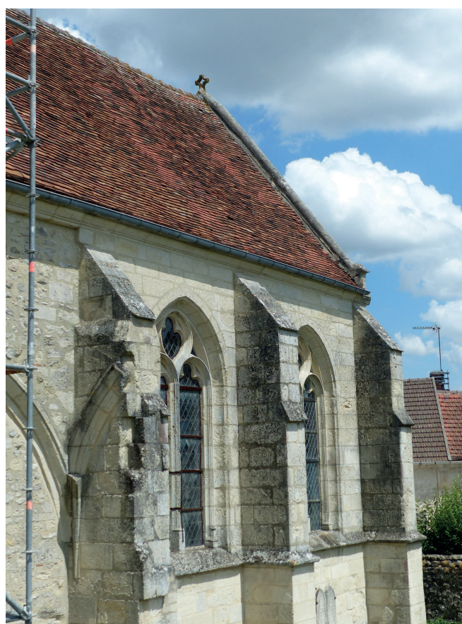
Comparaison entre l' US 208 et les contreforts voisins
