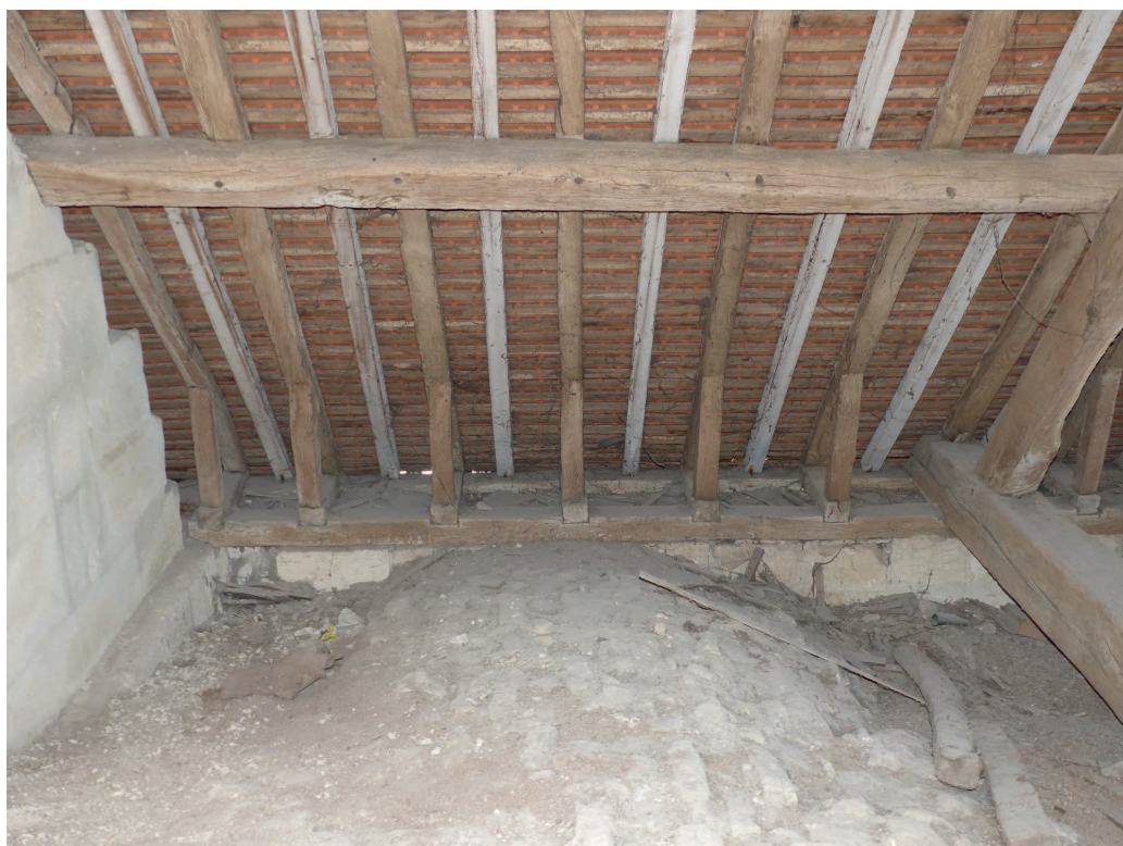
Détail des sablières de la charpente du chœur
