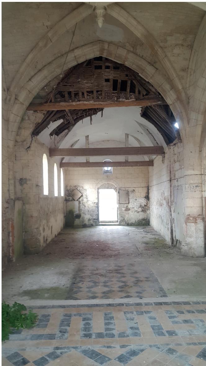
Vue générale de la nef avant l'opération
