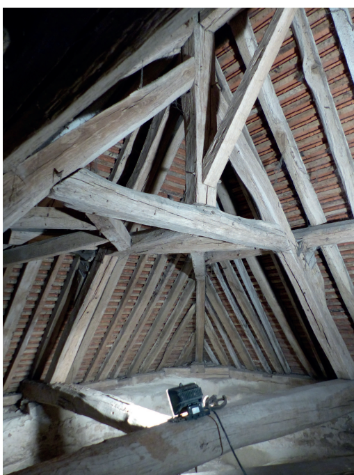
Vue d'ensemble de la ferme 1 du croisillon nord
