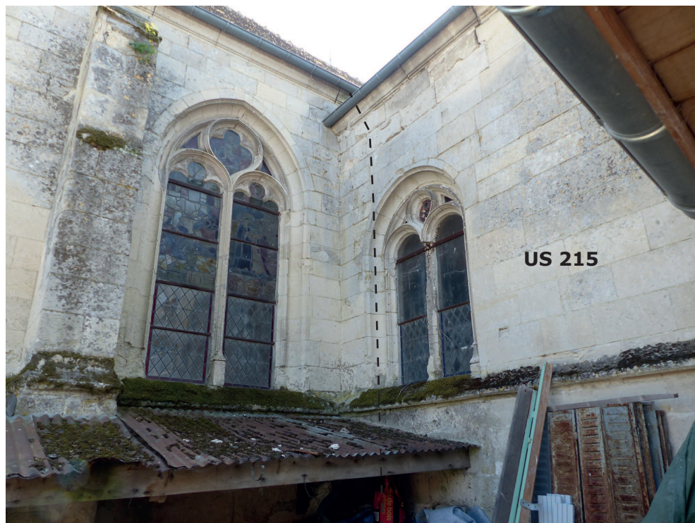
Détails de l'angle nord-est de la croisée
