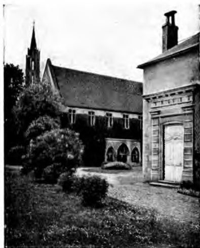
Prieuré Saint-Maurice dans l'enceinte du Vieux Château
