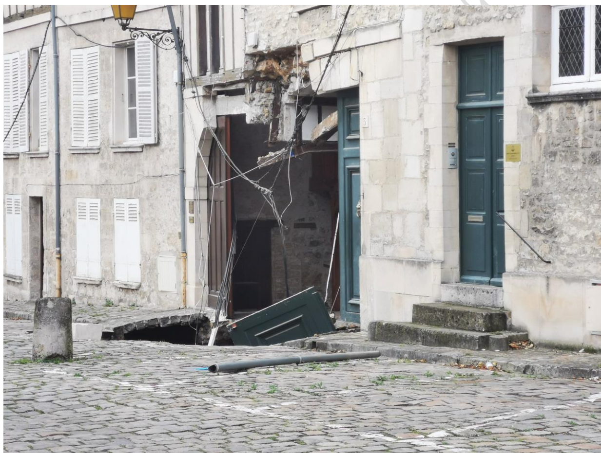
Le 8 novembre au matin, avant étayement et élargissement du trou © Jérôme Delécluse
