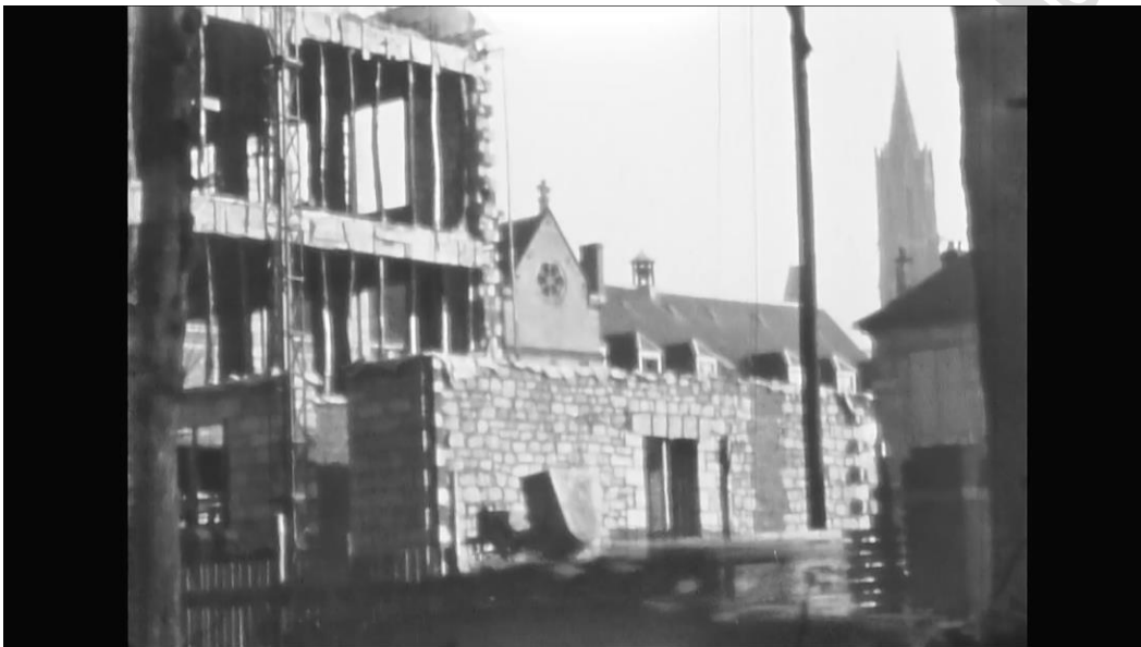
L'école Anne-Marie Javouhey en construction ©SHAS
