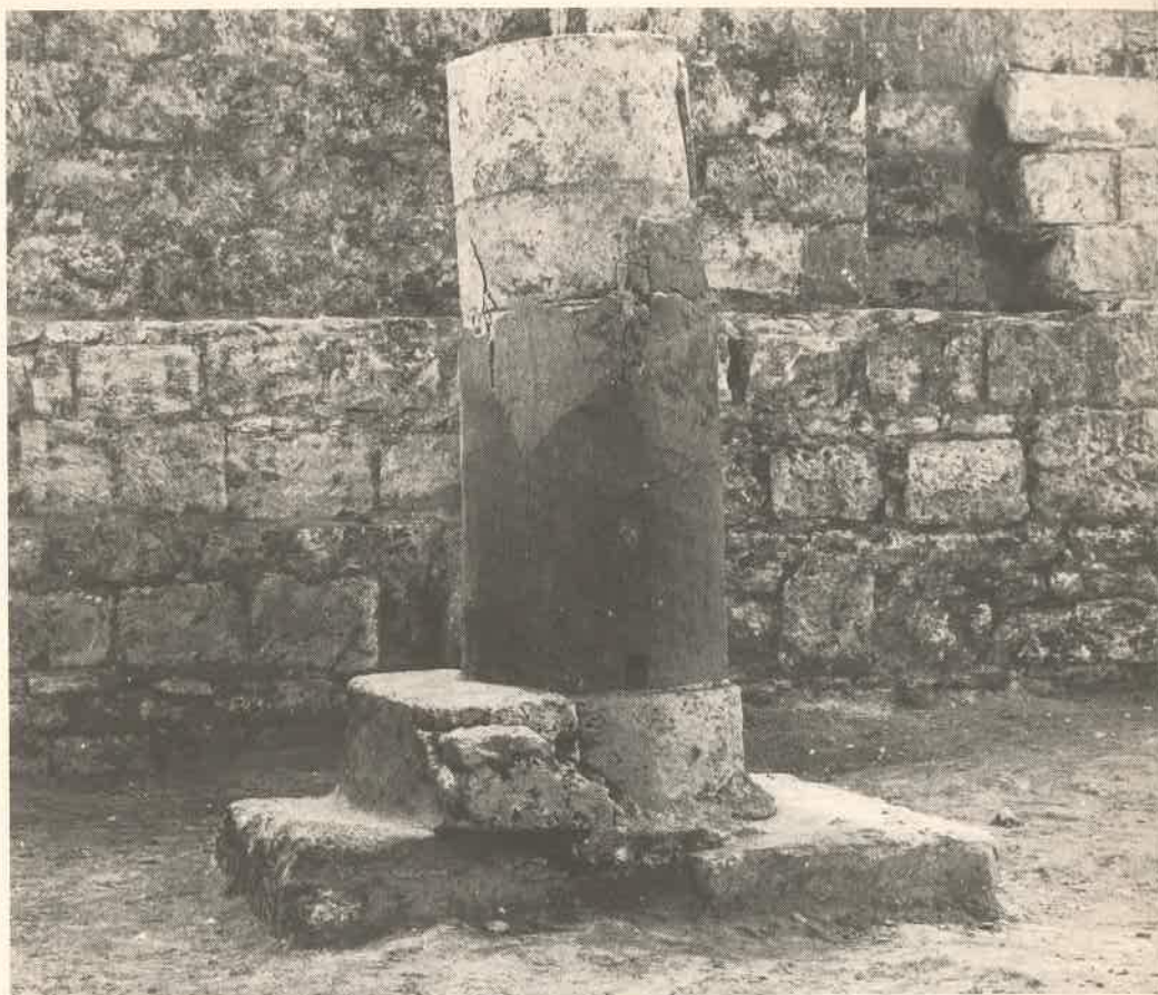
9. Colonne isolée de l'édifice prégothique. Le diamètre du tambour inférieur du fût est plus grand que celui des autres tambours et a été dissimulé sous un massif de plâtre, partiellement disparu (cl. P. Chéret).
