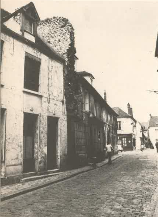
20. Le mur du cloître canonial de Saint-Frambourg près de la chapelle épiscopale. La rue du Chancelier-Guérin a éventré le mur du cloître. Au haut et à droite sur le cliché, on discerne le mur goutterot méridional de l'ancienne chapelle épiscopale (XII e siècle). A l'arrière-plan s'ouvre la place de la cathédrale de Senlis.
