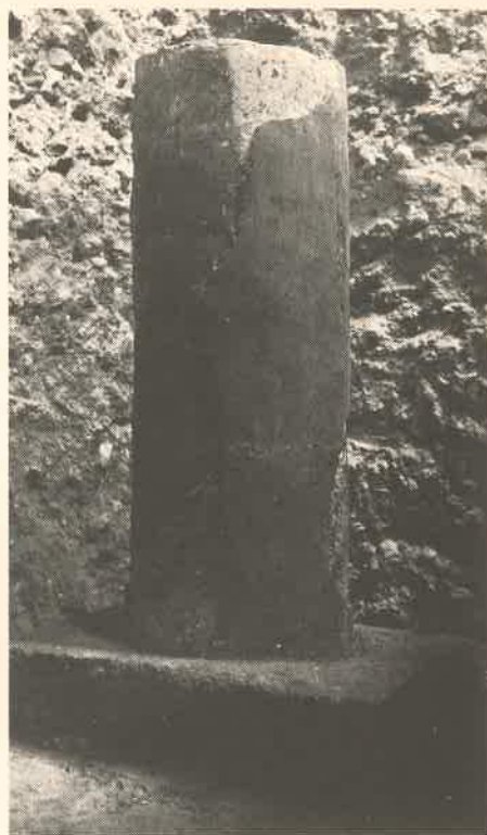
7. Fût isolé sur socle rectangulaire. Les tambours sont revêtus d'un manchon de mortier à tuileaux pilés (cl. P. Chéret).
