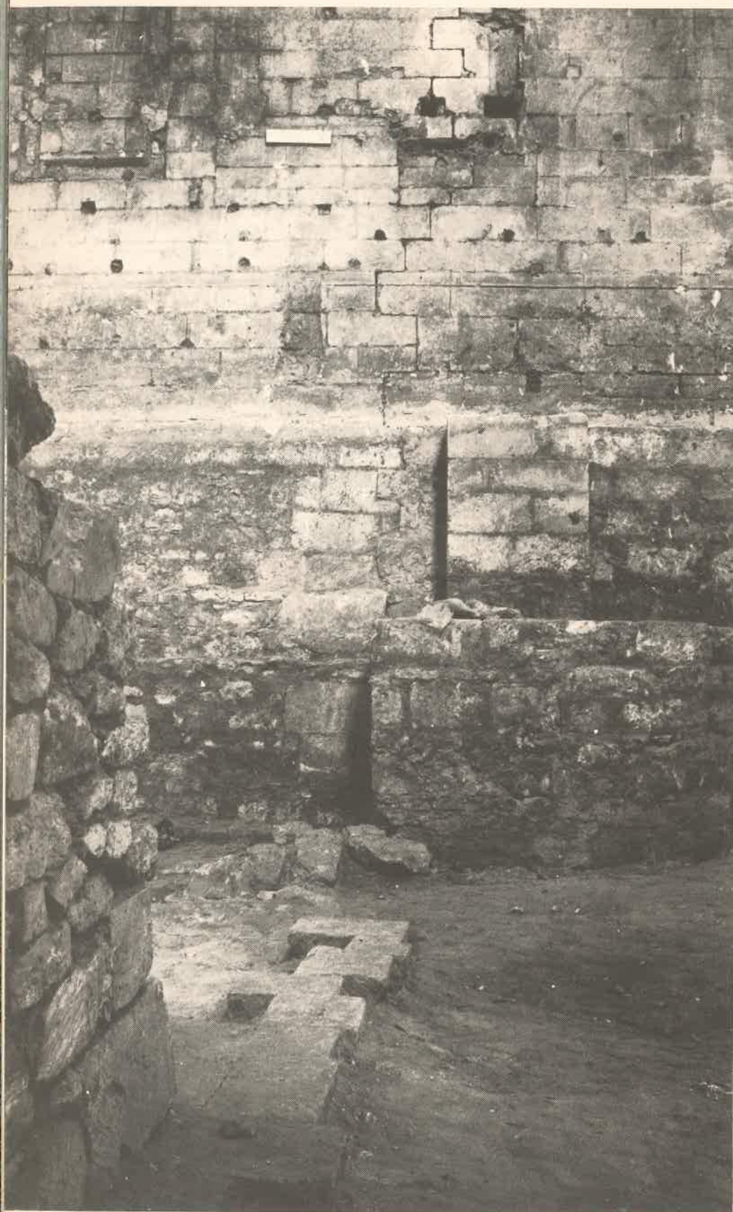
8 Les fondations du mur goutterot méridional de la nef gothique. Au premier plan à gauche, muret de fermeture, partiellement démonté, d'un chantier de fondations. Le dallage de l'édifice prégothique n'a pas été récupéré sous le muret et à ses abords immédiats. On notera, de part et d'autre du muret, la mutation du style des fondations et la « harpe » à redans qui traduit cette mutation dans l'appareil de l'élévation (cl. P. Chéret).
