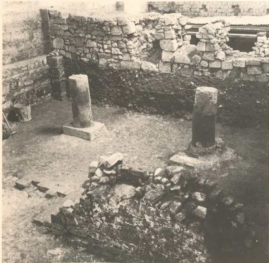
6. Colonnes de l'édifice prégothique. Au premier plan et à l'arrière-plan, murs fermant les chantiers des fondations gothiques. Le tronçon de mur au premier plan a enrobé l'une des colonnes isolées (cl. P. Chéret).
